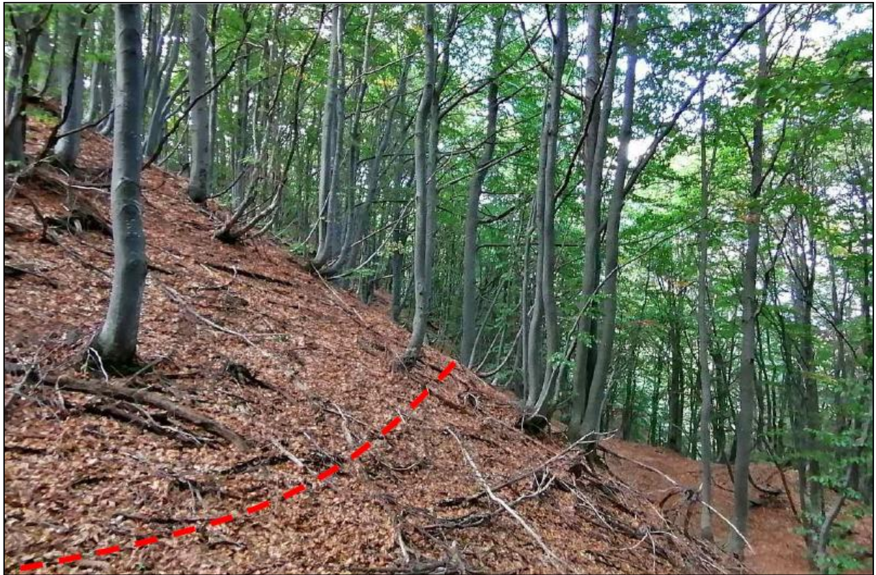
Foto 8 - Tracciato nella faggeta della parte iniziale della condotta di collegamento, tra il bacino d'invaso e la nuova stazione di pompaggio, senza particolari difficoltà dal punto di vista tecnico-operativo.
