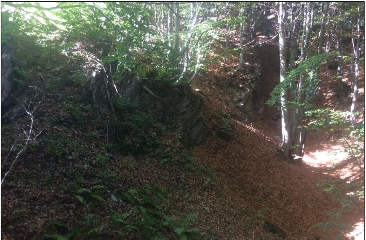
Foto 3 - Vista da valle della soglia naturale sottostante alla conca, in cui sarà intestato lo sbarramento, con disposizione degli strati a reggipoggio favorevole alla stabilità.
